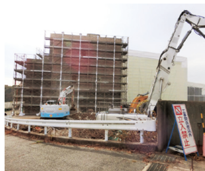
旧勝田清掃センター解体工事の様子
